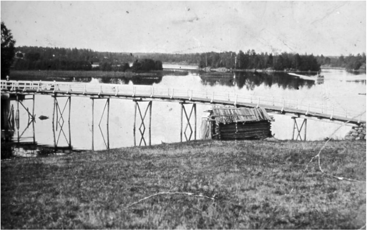
Unnunkosken isännät rakensivat talkoilla tämän yli 100 metriä pitkän silla Vuoksen yli. Tarpeet saatiin ympäristön talonpojilta lahjoituksina.
